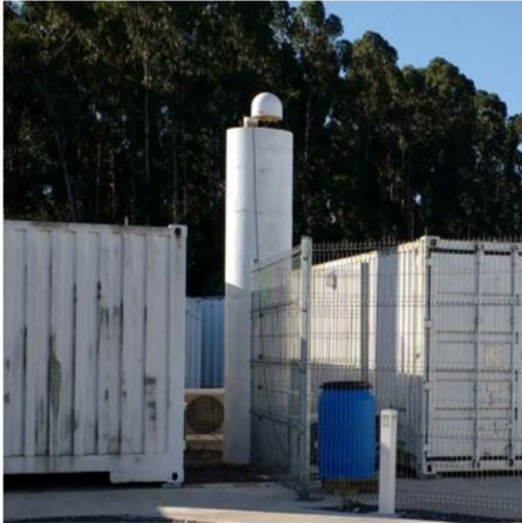
antena GNSS de dos frecuencias receptor Septentrio PolaRxTR4
